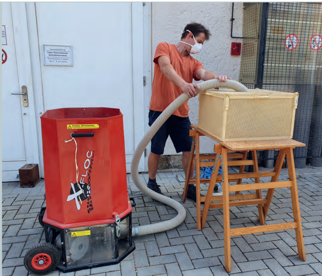
Abb. 2: Verarbeitungsversuch mit Einblasmaschine
