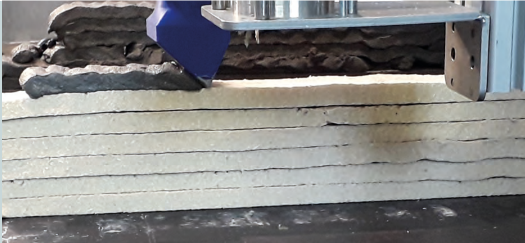
Abb. 1: Herstellungsprozess eines Demonstrators des kontinuierlichen Betonbaus
