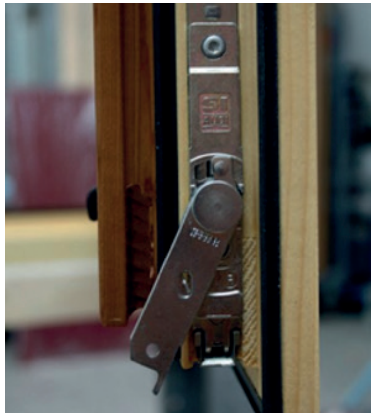
Flügelrahmen mit kombinierter Kantel; Außenlamelle aus TMT
