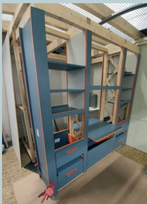
Abb. 1: Verkleidung und Möbelemente während der Montage (links) und fertiggestellte VarioWall (rechts)
