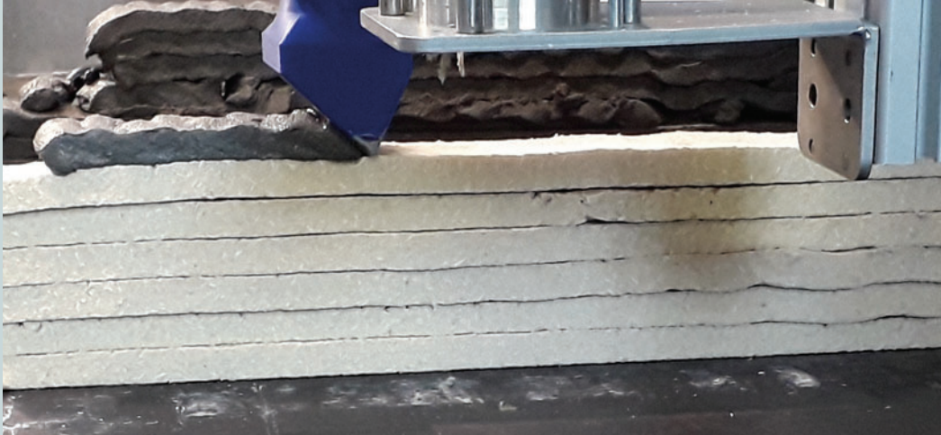
Abb. 1: Herstellungsprozess eines Demonstrators des kontinuierlichen Betonbaus
