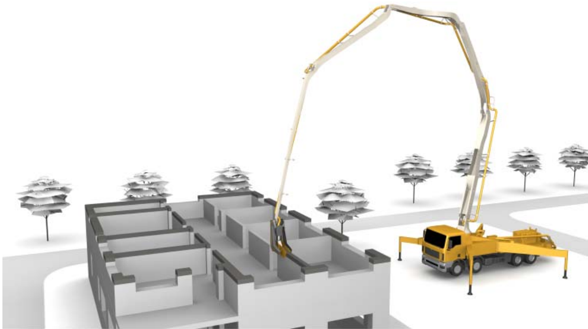
Abbildung 1: Darstellung der mobilen Beton-3D-Drucktechnologie ConPrint3D [Nerella et al. 2016]
