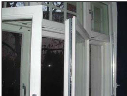
Abb. 1: Beispiel eines modernen Kastenfensters im Bestandsgebäude
