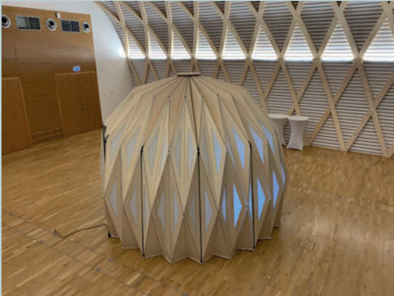
Abb. 1: Demonstrators eines Holz/Textil-Faltwerks in Form eines Pavillons
